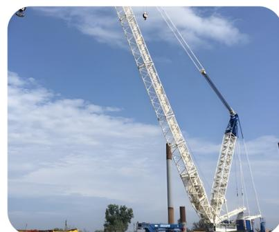
Гусеничный кран 250 тонн SANY SCC2500, выполняет работы по сборке свай (сварка и монтаж), а гусеничные краны Liebherr LR 1350 (350 тонн) и Liebherr LR 1750 (750 тонн), выполняют работы по забивке свай, с помощью гидромолота весом 96 тонн!
